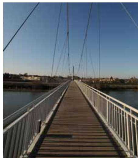
La passerelle entre Agen et Le Passage est une infrastructure communautaire
